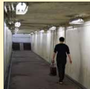
駅の東西をつなぐ少し薄暗い地下道。大雨の時には冠水の恐れがあるとか
